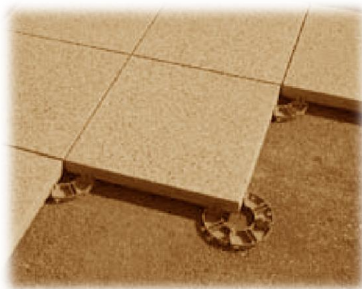
Pokládka na dilatační terče a izolací
