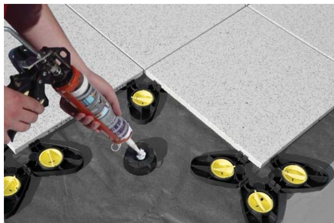
Pokládka dlažby Granex® na dilatační terče pro Granex®
