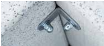
Detail spoje Jednoduchá montáž přímo na místě
